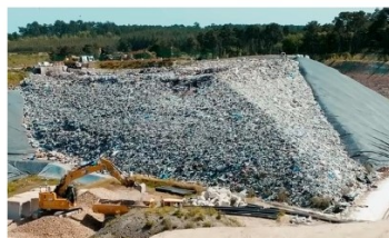
Enfouissement des déchets ultimes
